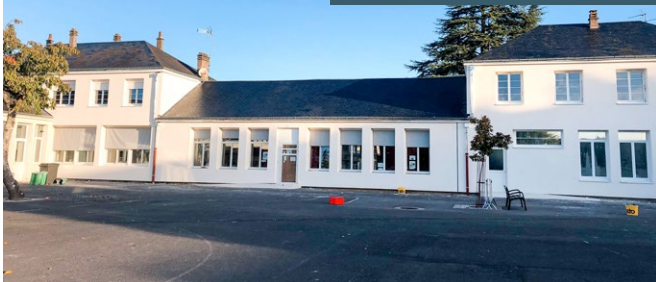
Rénovation thermique de l'école
