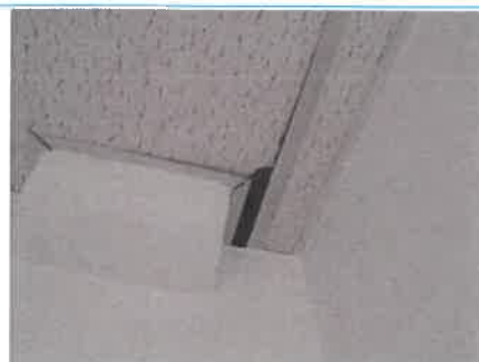
Matériaux : M008 Prélèvement : P008 Description : Faux plafonds Localisation : Rez de chaussée - ENTREE Résultat : Absence d'amiante Quantité :
