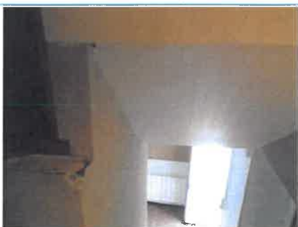
Matériaux : M009 Prélèvement : P009 Description : platre + peinture Localisation : 1er étage - ESCALIER Résultat : Absence d'amiante Quantité :
